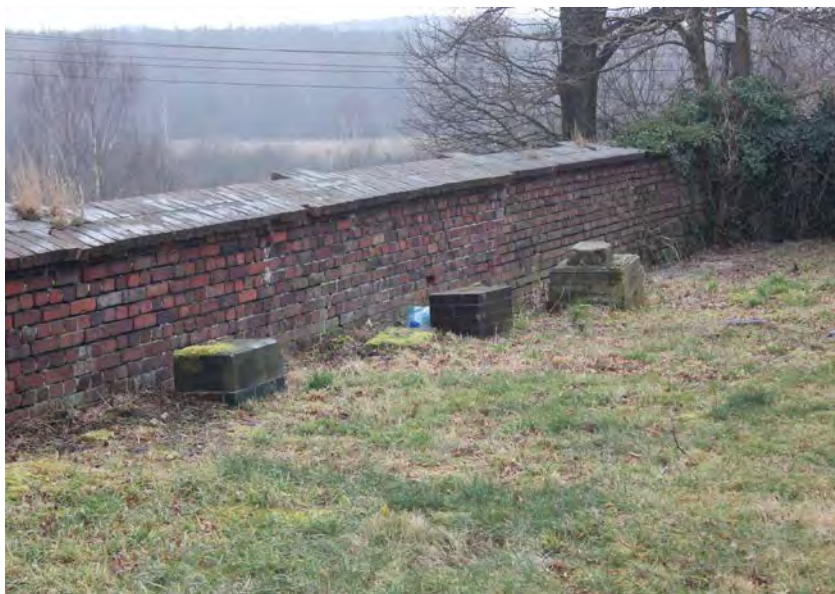
Miostowice Dolne (cokoły przy kościele)
