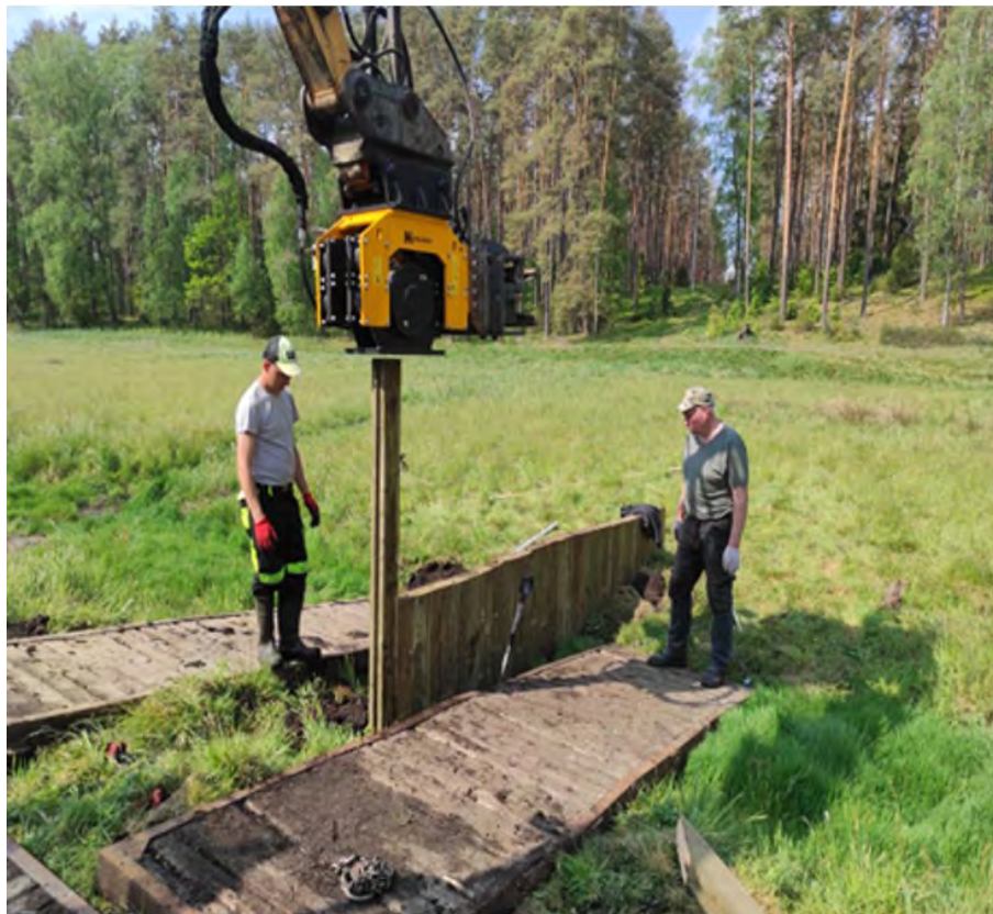
Rycina 5 Budowa ścianki szczelnej w oddz. 33p (Leśnictwo Lipce).
