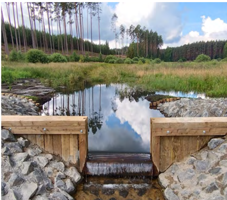
Rycina 6 Kamienne umocnienie progu piętrzącego oddz. 33p (Leśnictwo Lipce).
